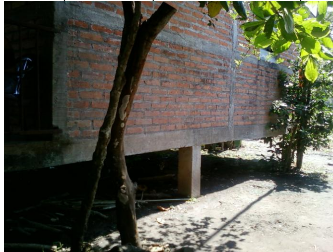
Figura 44. Vivienda elevada para evitar que resulte afectada por inundaciones.
