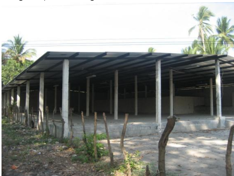
Figura 9. Refugio ubicado en Comunidad El Chino. Se observa que el nivel de piso terminado se ha 0.40 mt del nivel del terreno.
